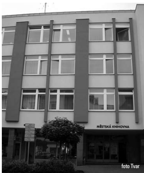
Zrekonstruovaná budova Městské knihovny Benešov
