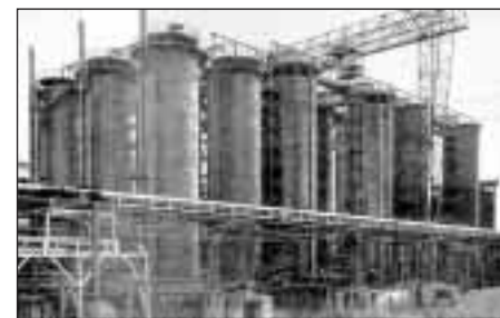
Výroba amoniaku v Opatov: Absorpční věže na výrobu kyseliny dusičné, z knihy Obrazy z německého dusíkového průmyslu
